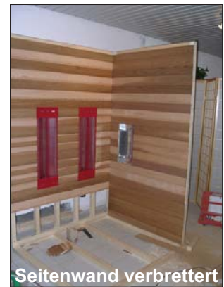
Strahler eingebaut
